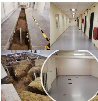
Figura 1 Instalación de pozos en el interior del edificio y restauración del suelo
